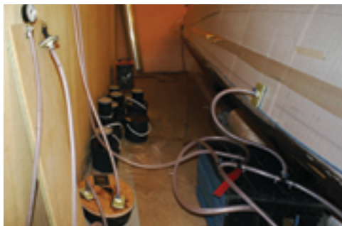
Pumper og slanger gøres klar til selve indsprøjtningen.
